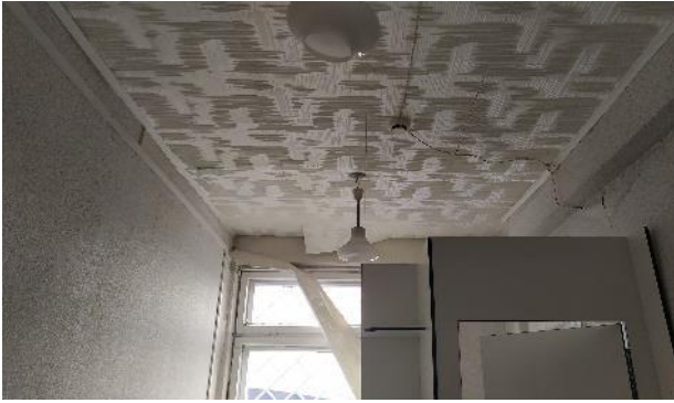
Фотография 17. Фрагменты внутренних помещений объекта оценки
