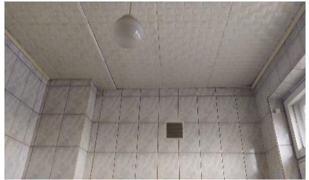
Фотография 10. Фрагменты внутренних помещений объекта оценки
