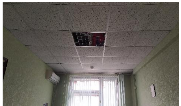
Фотография 12. Фрагменты внутренних помещений объекта оценки
