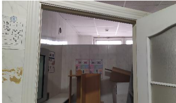
Фотография 4. Фрагменты внутренних помещений объекта оценки
