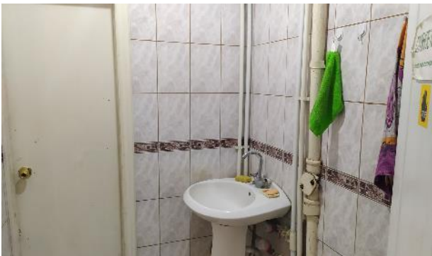
Фотография 7. Фрагменты внутренних помещений объекта оценки
