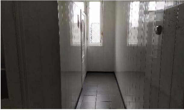
Фотография 1. Фрагменты внутренних помещений объекта оценки
